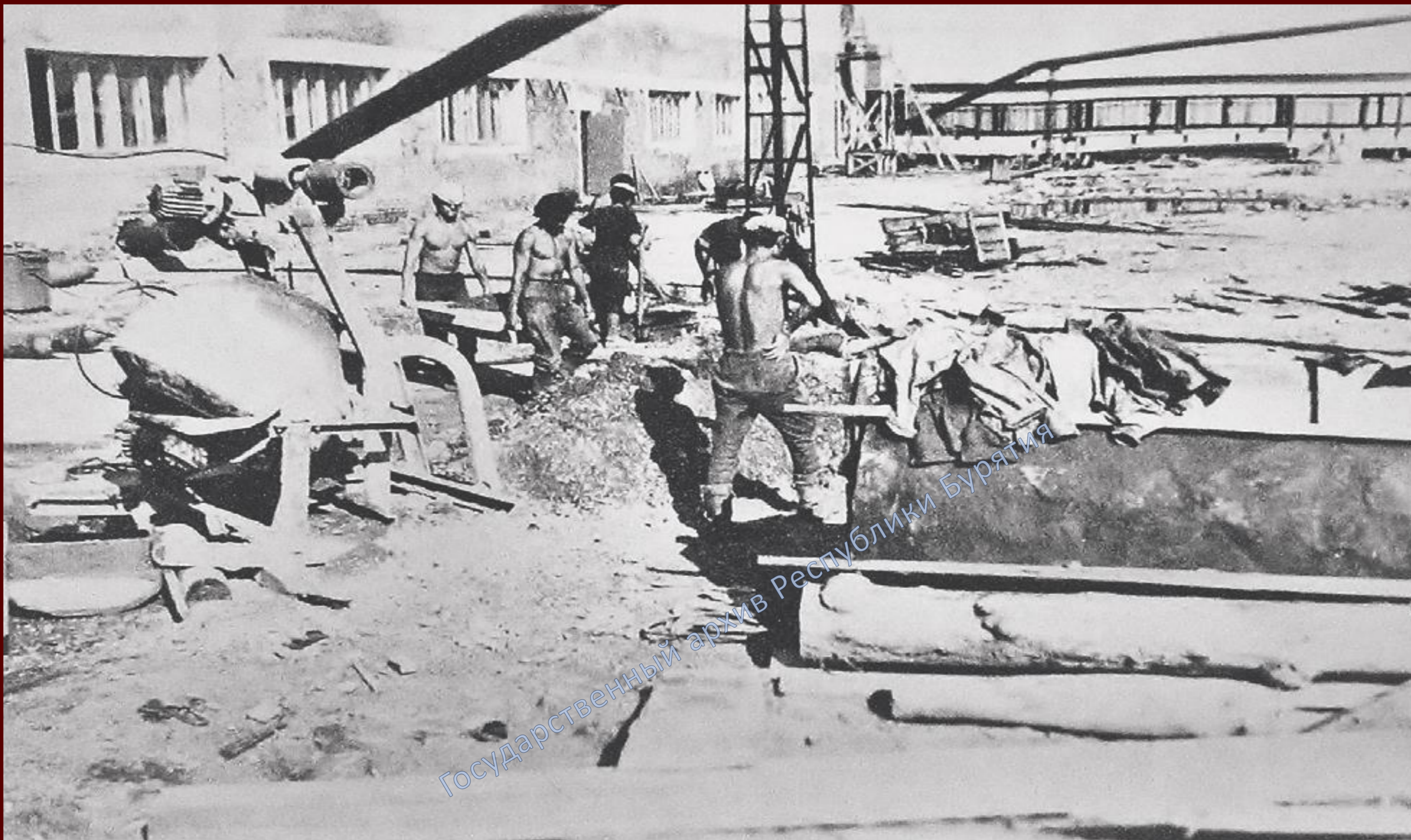
Бойцы студенческого строительного отряда «Бригантина» Бурятского педагогического института (бригадир В. Житихин), производят заливку отмостков вокруг здания лесотарного цеха Байкальской лесоперерабатывающей базы в с. Выдрино. Кабанский район, 1973 г.
