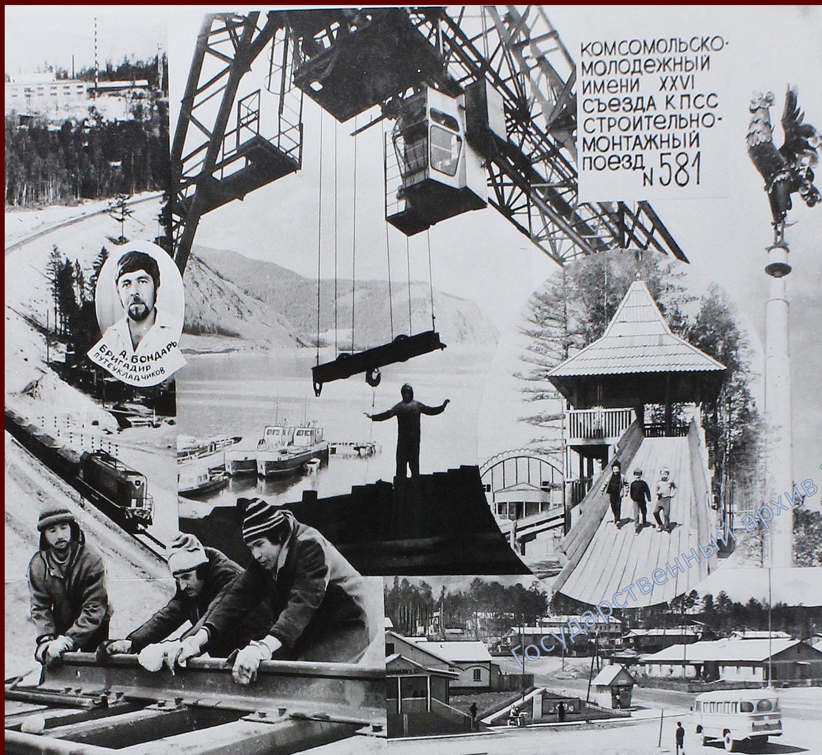
Строители комсомольско-молодежного отряда имени XXVI съезда КПСС Строительно-монтажного поезда № 581. Без даты. Фотофонд ГАРБ
