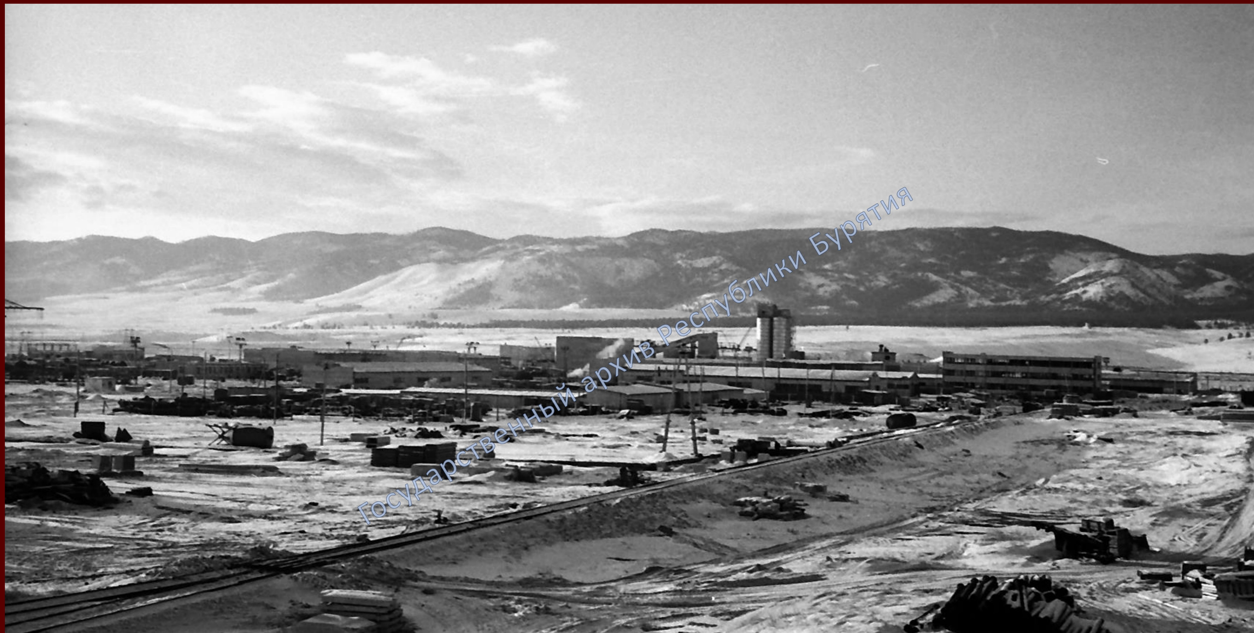
Начало строительства Гусиноозерской ГРЭС.
