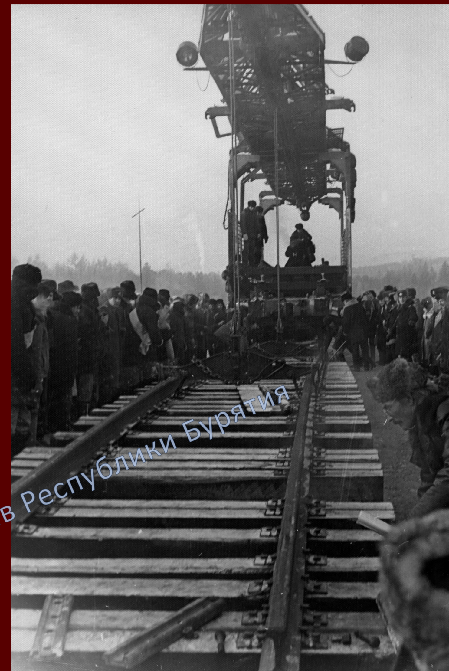
Укладка серебряного звена на входной стрелке станции Таксимо. На укладке лучшие представители бригад - А. Бондарь, М. Кокорин, Л. Боров и др. 1983 г. ГАРБ. ФП.36. Оп.29. Д.60. Л.1 об.-2
